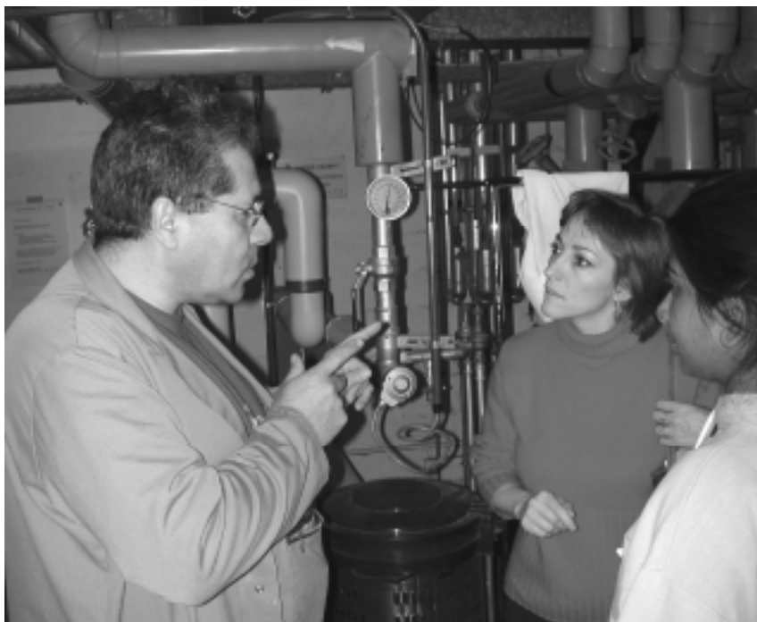
Carlos explique le fonctionnement de la chaufferie au nouveau personnel
