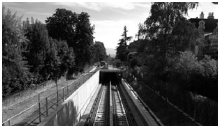
Les tout nouveaux rails du m2 sur le tracé de La Ficelle
